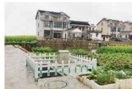
▲ 常熟市海虞镇生活污水治理项目
