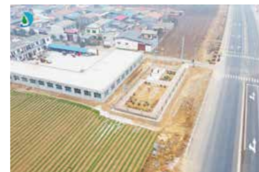
▲ 河南许昌生活污水处理项目
