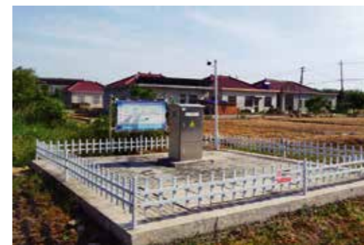
▲ 扬州市江都区生活污水治理项目
