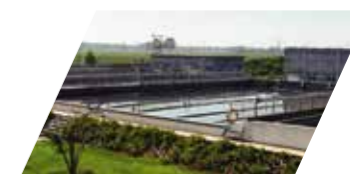
城镇污水提升
