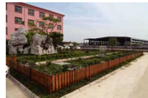
▲ 无锡市江阴生活污水处理项目
